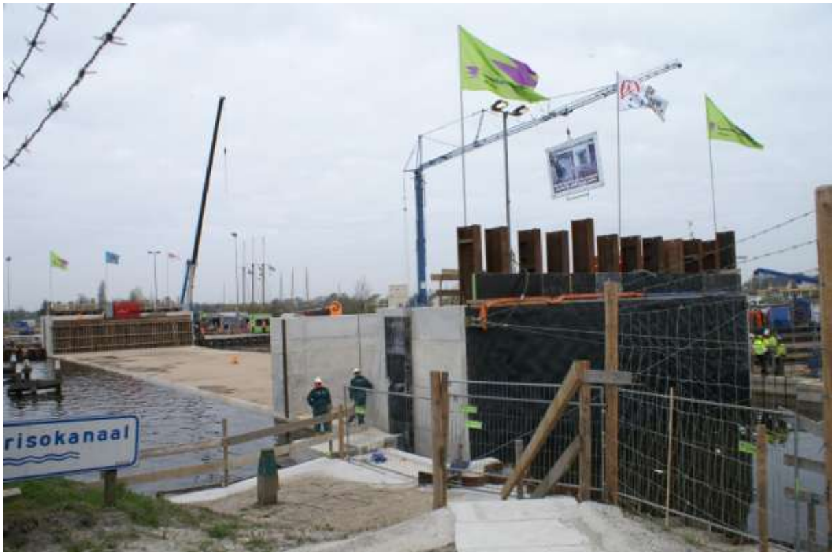
Aanleg van het aquaduct bij Galamadammen.
